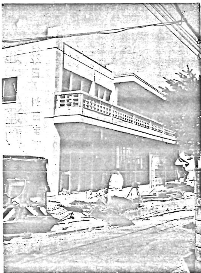
【写真】完成した第11張所
