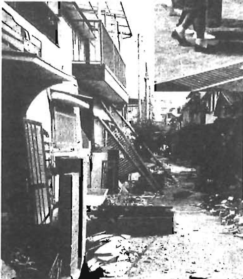
▼阪神淡路大震災による被害
