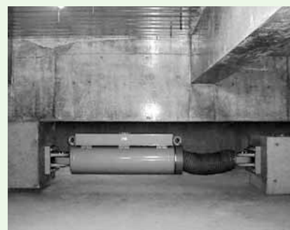
▲免震装置に組み込まれる積層ゴムとオイルダンパー
