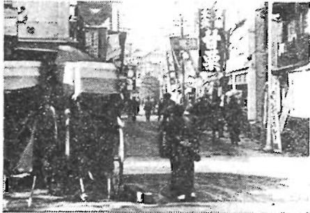
昭和初期の池袋駅西口付近
