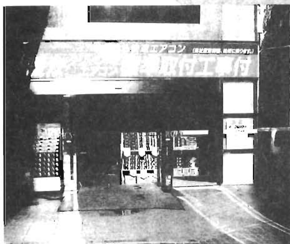
スロープによって入口の段差を解消
