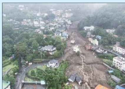
令和3年大雨による土砂災害 (静岡県熱海市伊豆山)
